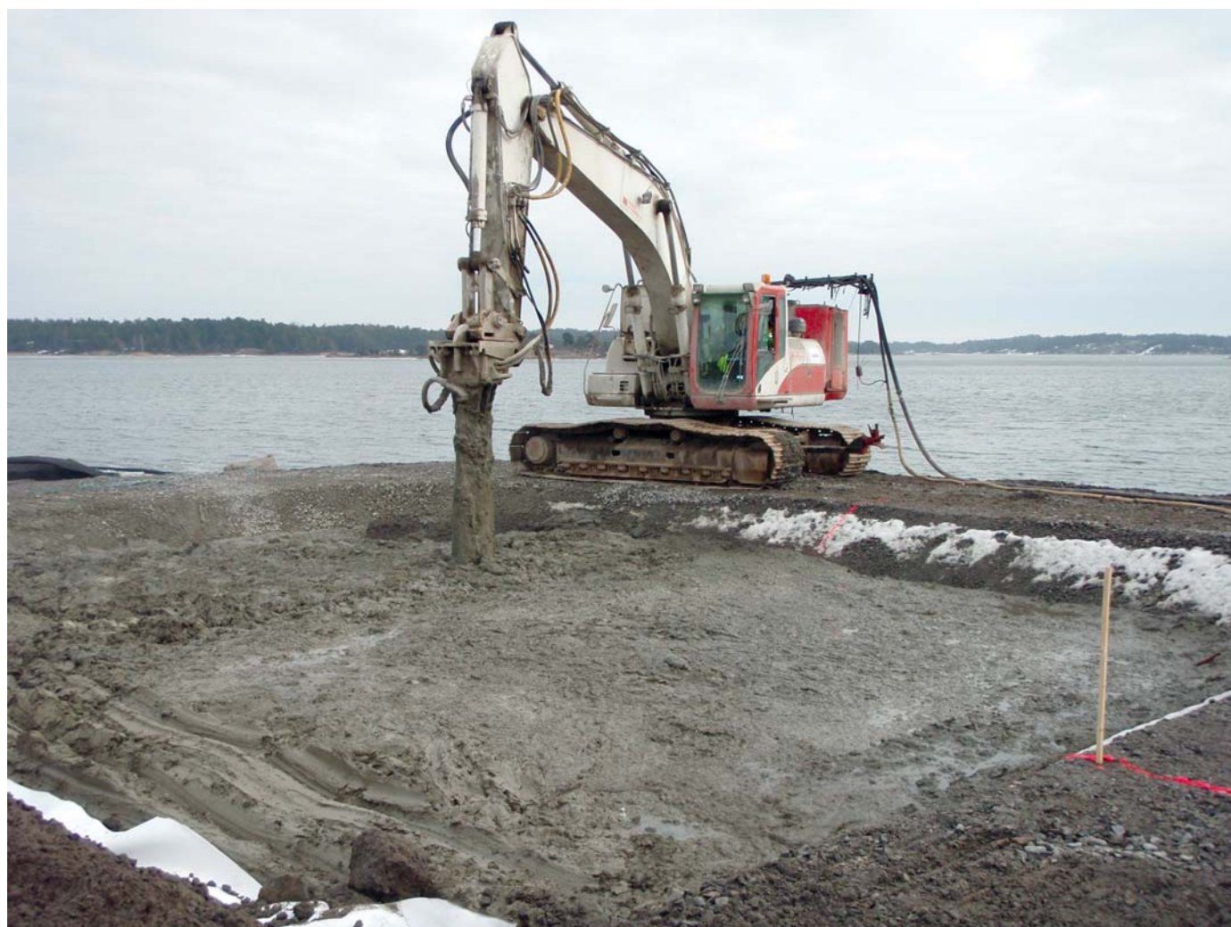
Figur 1. Utförande av stabiliseringen vid fältförsöket i Stegeludden, Oxelösund.
