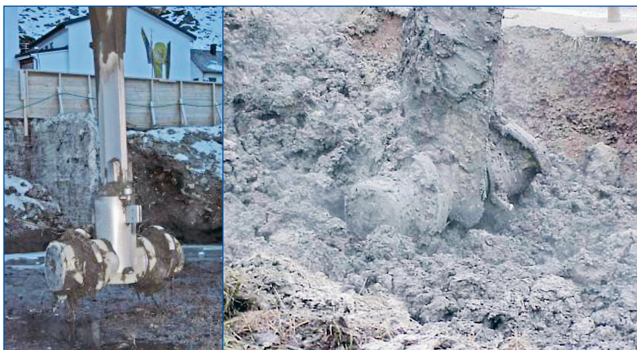
Figur 10: Masstabiliseringsverktyg som användes i Hammerfest till vänster och väg 32 till höger.
