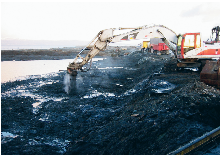
Figur 11: Exempel på stabilisering av förorenade muddermassor, Trondheim.
